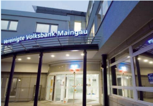
Komplett DAIKIN klimatisiert: Die Zentrale der VVB.
